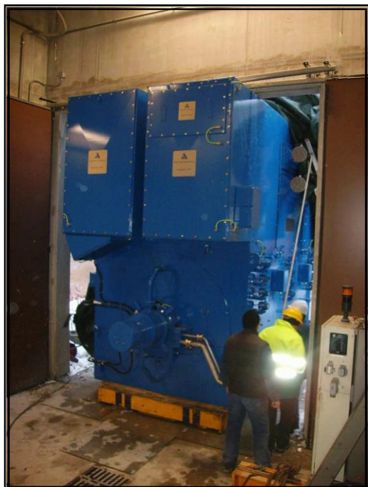
Introduzione all'interno del fabbricato e montaggio alternatore.
