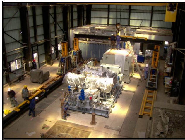
Fase di montaggio della turbina ed alternatore con sollevatori idraulici.
