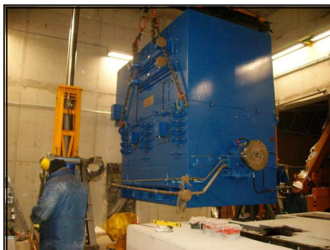
Introduzione all'interno del fabbricato e montaggio alternatore.
