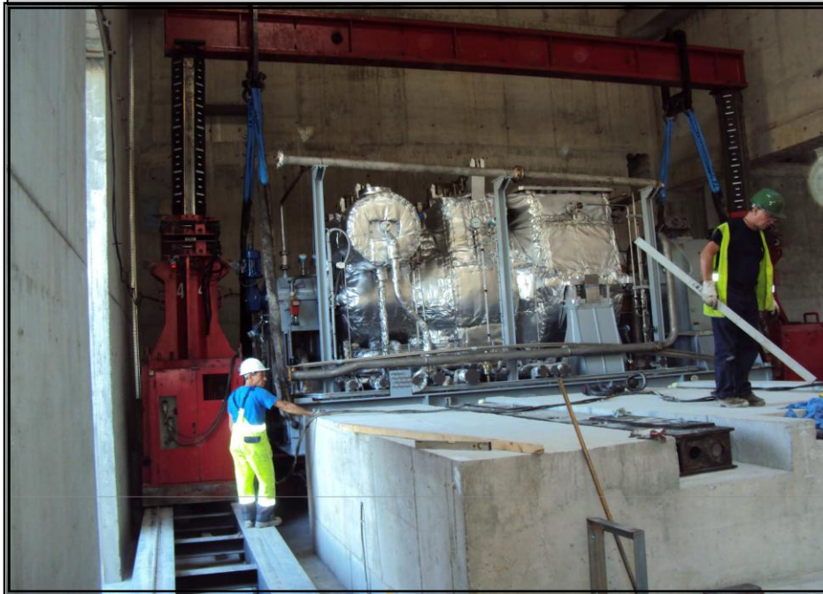
Montaggio centralina olio.
