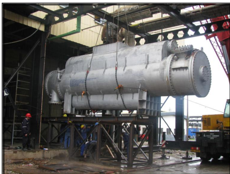
Montaggio condensatore acqua mare (27 tons) con strutture provvisorie. Sea water condenser (27tons) installation with temporary structures.
