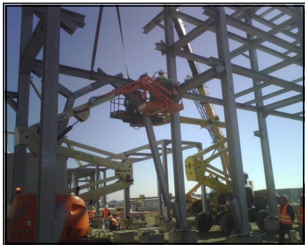
Montaggio strutture pipe rack.
