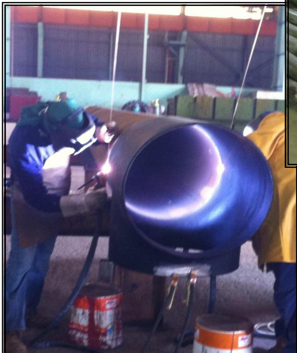
Saldatura in TIG tubazioni. TIG welding
