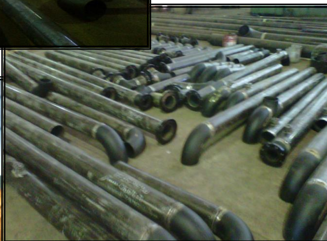
Approntamento tubazioni per saldatura. Piping preparation before welding
