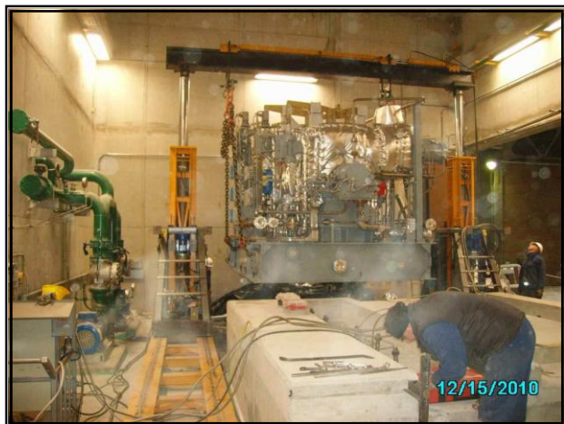
Fase di montaggio della turbina con sollevatori idraulici.
